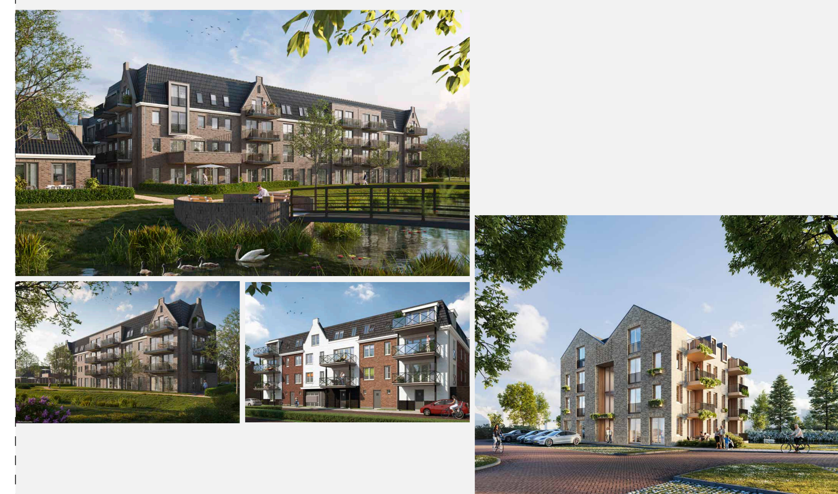
Appartementen (urban villa)
